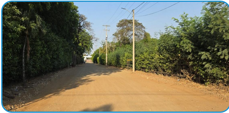
1. Estado Inicial de la vía
