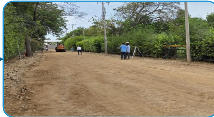
5. Nivelación y compactación
